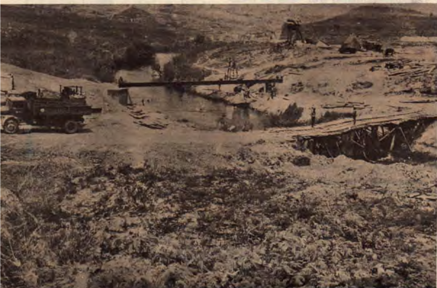
Construção duma ponte pela C. E. 3336, alguns no leste
